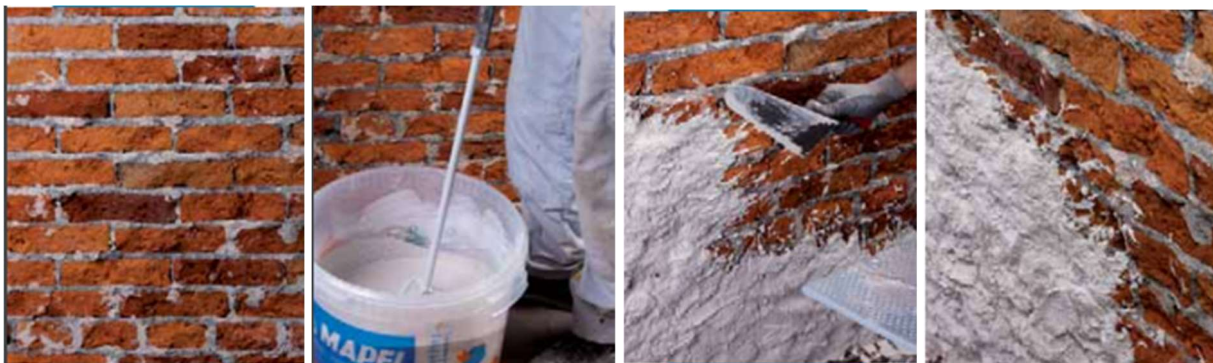
Slika 54. Proces nanošenja temeljne žbuke
