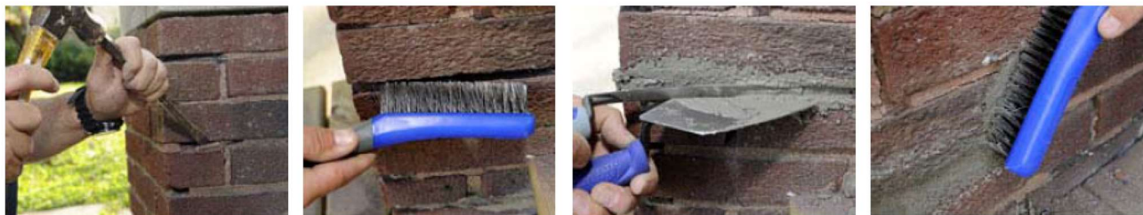
Slika 40. Djelomična zamjena morta u sljubnicama
