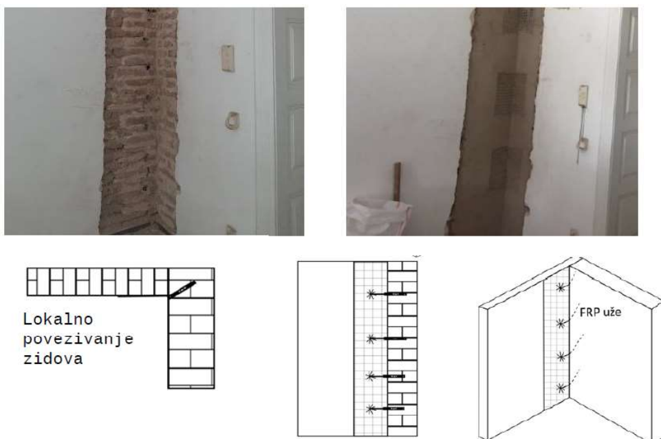
Slika 45. Sanacija spoja nosivih zidova
