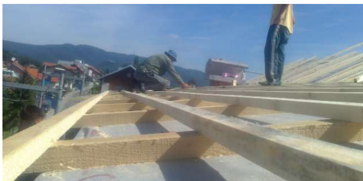
Slika 57. Letve i kontraletve na foliji
