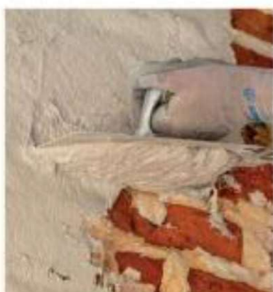
Žbukanje reparaturnim mortom
