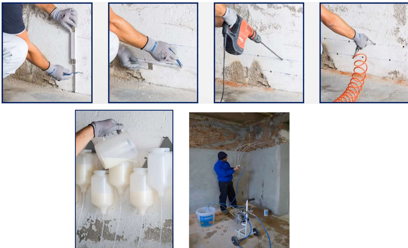
Slika 53. Izvedba kemijskog prekida kapilarne vlage
