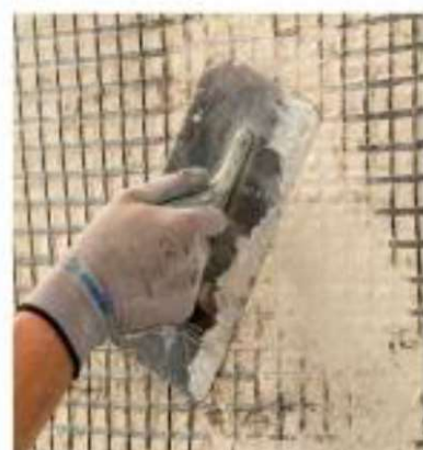
Ugradnja FRCM sustava
